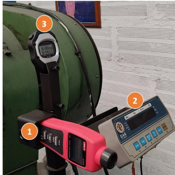
10. Figura 13: Soporte con indicadores visuales instalados.
