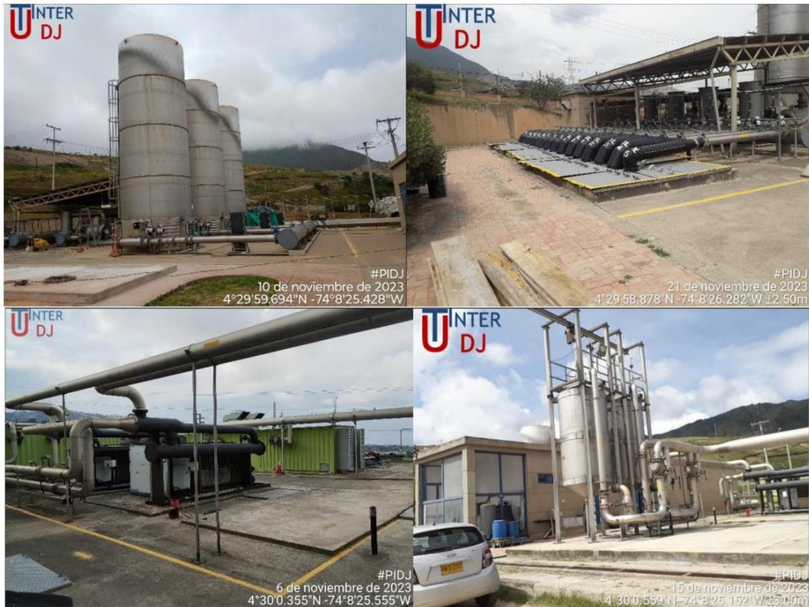
Figura 9-6. Fotografías de la Planta de Biogás. a) Antorchas quemadoras de Biogás, b) Sopladores de biogás, c) motogeneradores de energía, d) filtros de carbón activado.
