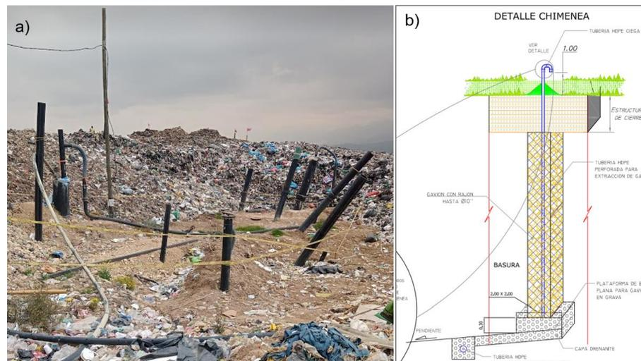
Figura 9-4. a) Chimeneas en Doña Juana. b) Diseño inicial de las chimeneas.
