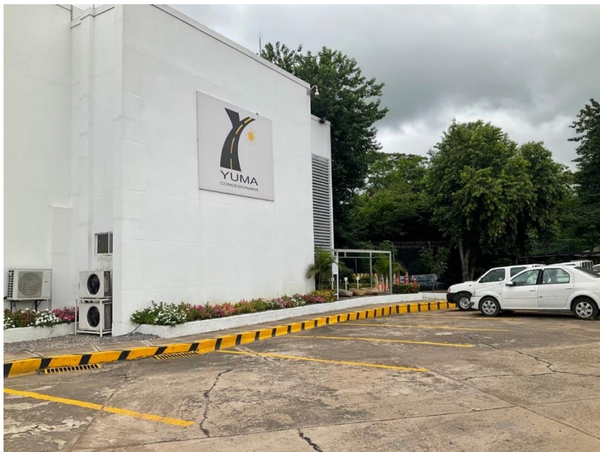
Figura 1-6. Parte exterior del edificio de Yuma Concesionaria.
