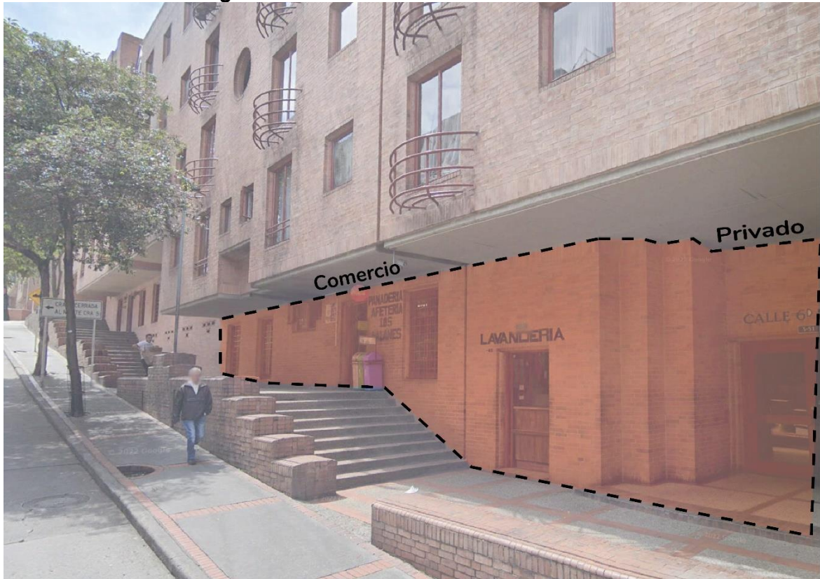
Figura 3-5. Fachadas activas Nueva Santa Fe
