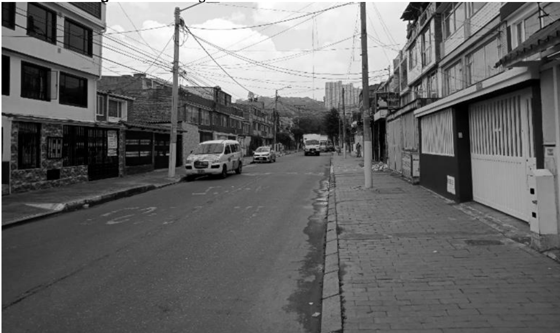
Figura 4-39 Fotografía estado actual calle comercial - Actual
