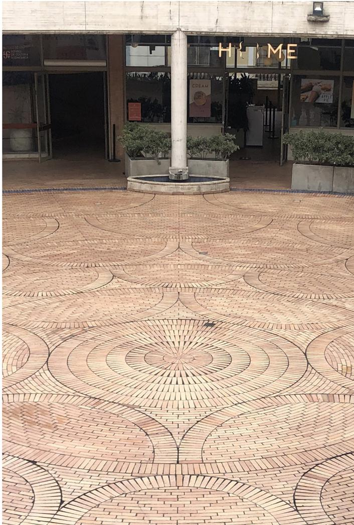
**Figura 182.** (izquierda) En el Fondo de Cultura Económica, la disposición del aparejo de ladrillo permite leer las geometrías del círculo a pesar del uso de ladrillo de un único tono.
