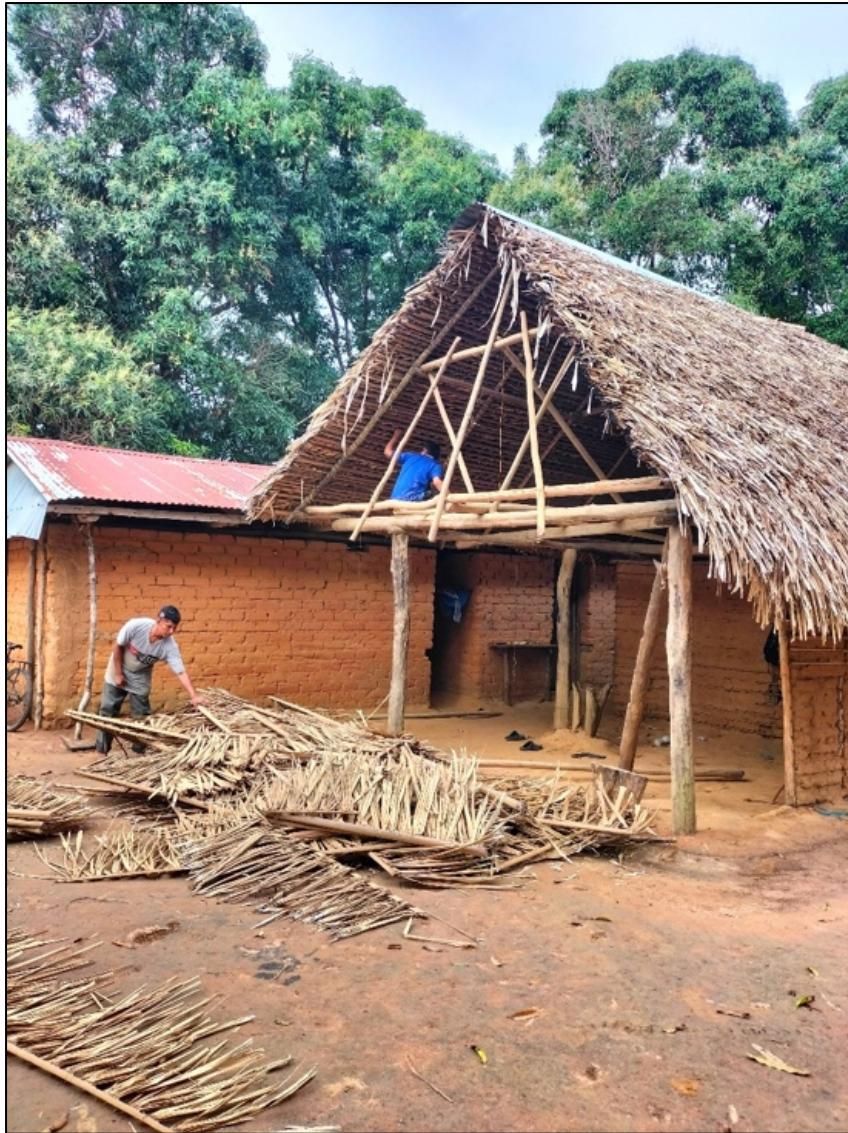
Figura 24. Desmonte de una casa de madera y techo de palma. Fotografía tomada por el autor el 28 de febrero de 2022
