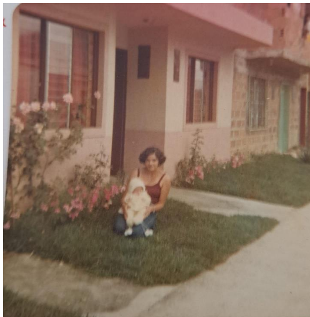
Figura 3.33: Fotografía de fachadas de viviendas con antejardín
