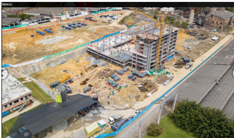
Figura 4.15: Avance de obra del proyecto Indigo.
