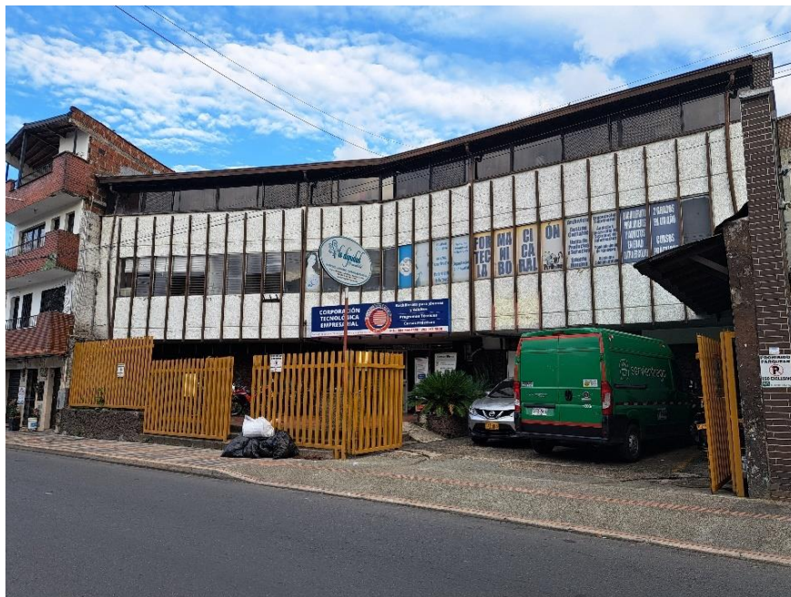
Figura 3.23: Antigua Sede de sindicato de Coltejer, hoy oficinas de distintos usos.
