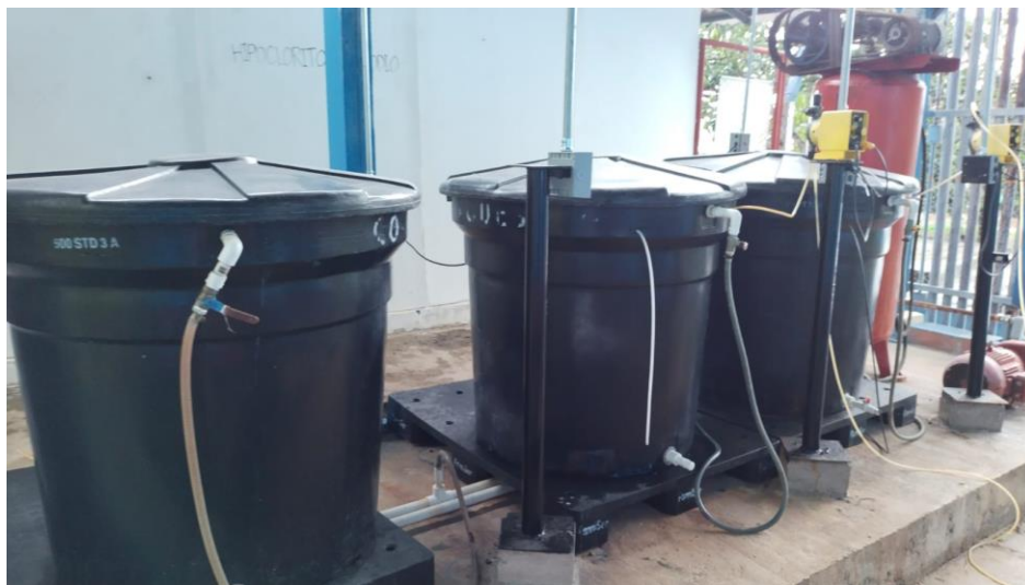
Figura 15. Tanques de preparación y dosificación de químicos (coagulante – cloro)
