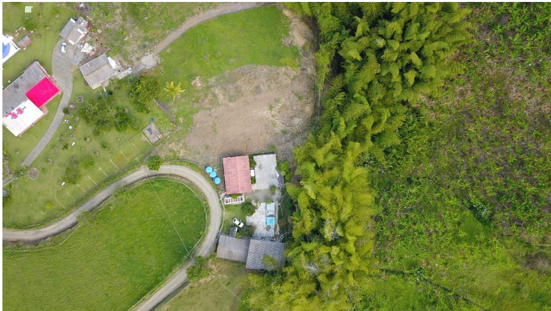
Figura 4. Vista superior del sistema de tratamiento de agua potable, San Antonio
