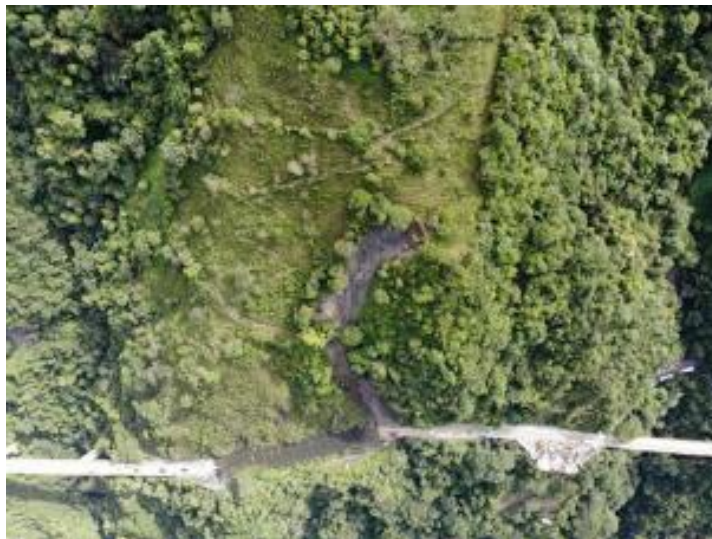
Figura 6.11.1. Inicio del deslizamiento en el PR64+200, 14 de julio de 2018.
