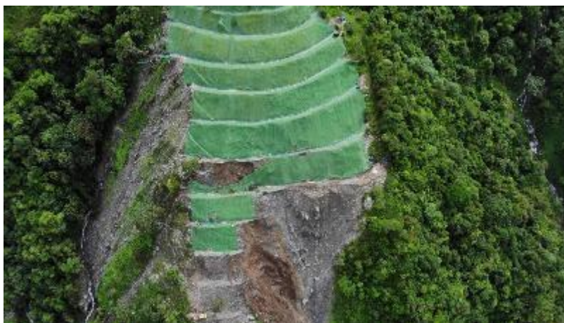
Figura 6.11.2. Obras de estabilización de la ladera, 15 de mayo de 2019.
