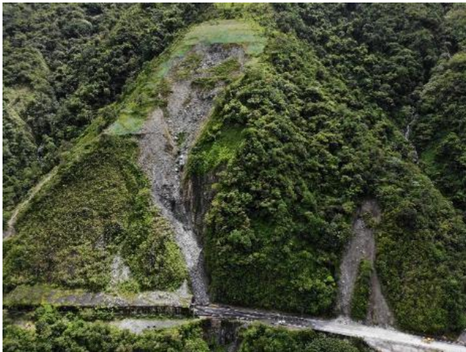
Figura 6.11.4. Desprendimiento del PR64+200. Junio de 2020.
