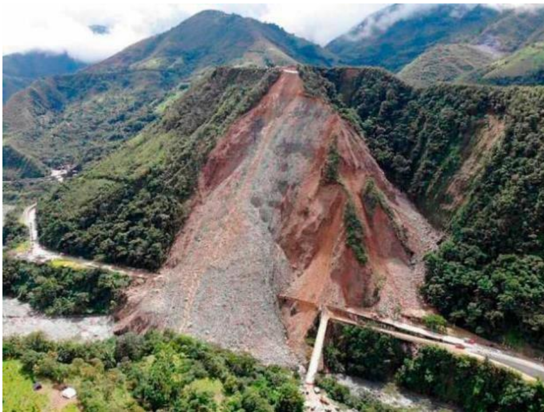
Figura 4.9.2 Deslizamiento Meseta Mesagrande K58 de la Vía Bogotá – Villavicencio.
