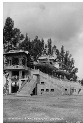
Im. 14. Edificio de Tribunas del Hipódromo Alfonso López (1930) Arquitecto: Vicente Nási Fotografía Gumersindo Cuellar.
