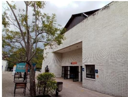
Foto 43. Edificios en bloques de hormigón reciclado.
