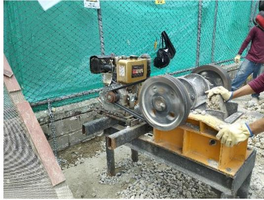
Fotos 59 y 60. Demolición placa de hormigón (izq.); trituración de los escombros (der.).
