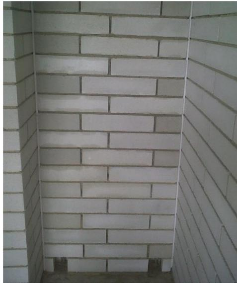
Foto 49. Pared en mampostería con bloques de hormigón reciclado blanco.
