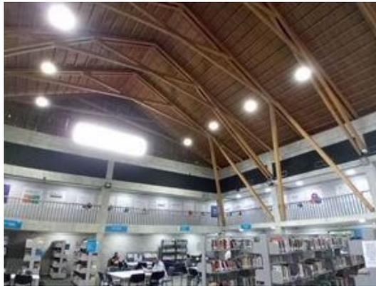
Foto 46. Cubierta con estructura de madera, en contraste con las paredes de hormigón reciclado.
