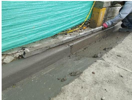
Fotos 65 y 66. Placa vaciada y recorrida (izq.); Recorrido de cuneta de hormigón con codal.
