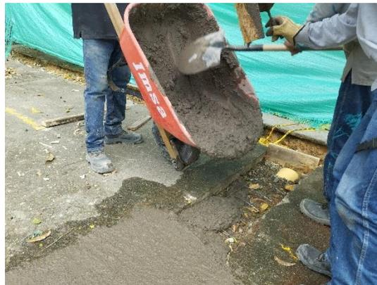
Fotos 63 y 64. Confección del hormigón (izq.); Vertido y colocación del hormigón (der.).
