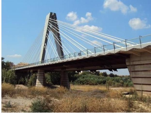
Foto 53. Puente en concreto reciclado.
