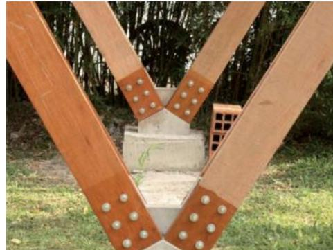
Fotografía 8. a) Pedestal de hormigón; b) columna de madera apoyada en el hormigón.
