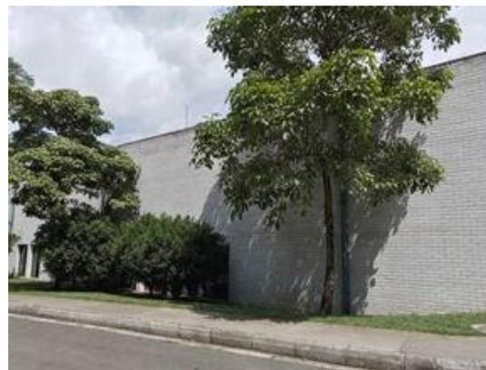
Foto 44. Paredes en bloques de hormigón reciclado.
