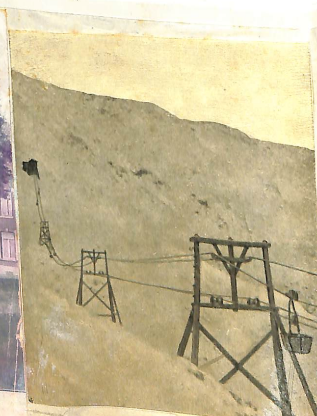
Vía aérea destinada al transporte de carbón para las Usines et Mines de Houille du Grand-Hornu, St. Ghislain (Bélgica). Tronco de línea con rendimiento por hora de 187 toneladas.
