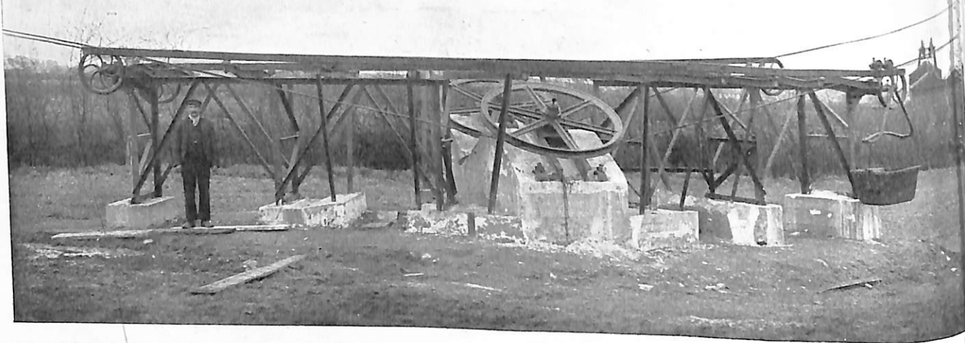
Estación de ángulo. Cable Aéreo de la INTERNATIONAL SALT COMPANY, LIMITED, Carrickfergus, Irlanda.
