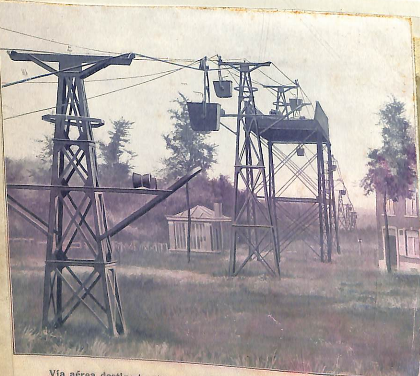
Vía aérea destinada al transporte de carbón para las Usines et Mines de Houille du Grand-Hornu, St. Ghislain (Bélgica). Tronco de línea con rendimiento por hora de 187 toneladas.
