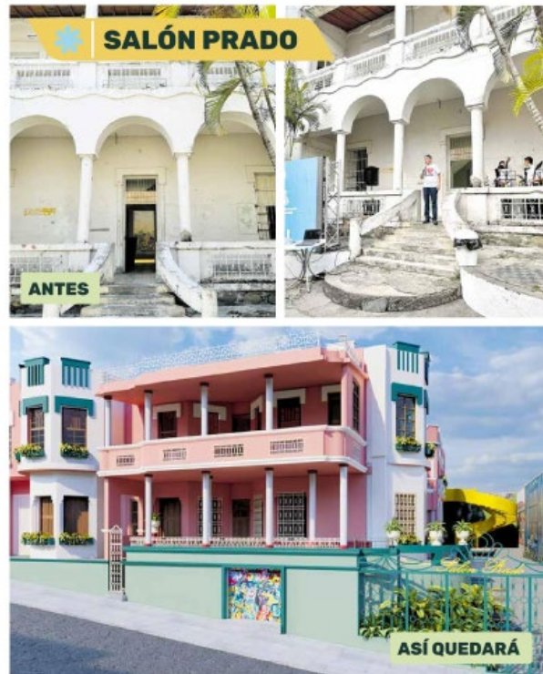
Figura 4-2: Adecuación del Salón Prado.
