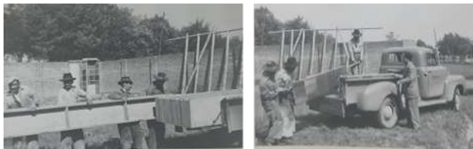
Figura 3-5: Cargue de elementos prefabricados por parte del equipo CINVA
