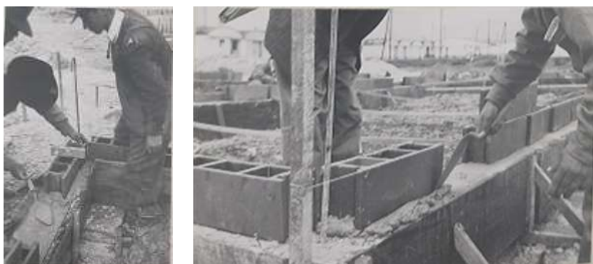
Figura 3-6: Colocación de bloques de 13 cm de altura
