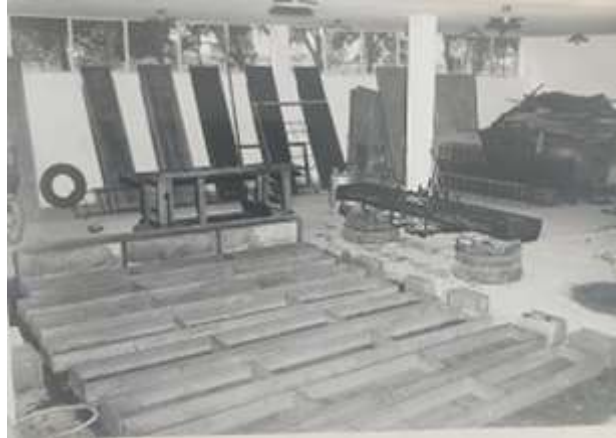
Figura 3-3: Taller con formaletas y elementos prefabricados
