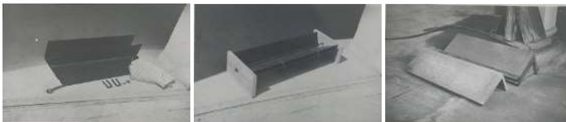
Figura 3-2: de izquierda a derecha dos tipos de formaletas de escalones y resultados
