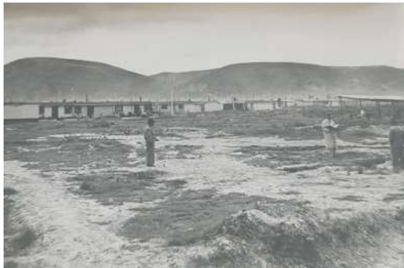
Figura 3-4: Vista del lugar de emplazamiento de la casa experimental en el barrio Quiroga
