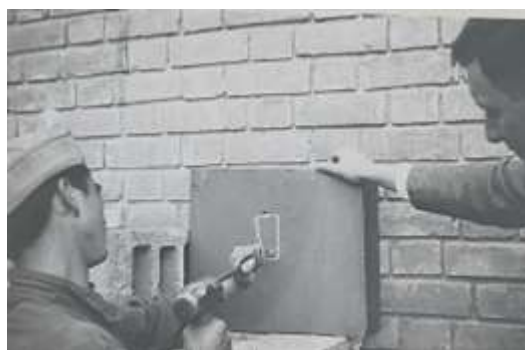
Figura 3-7: Ejecución de agujeros en los bloques para la fijación de cajas de eléctricas
