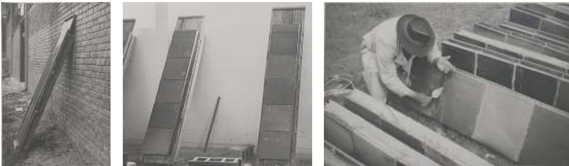
Figura 3-1: de izquierda a derecha bases para armado de los paneles de bloques y revisión de juntas
