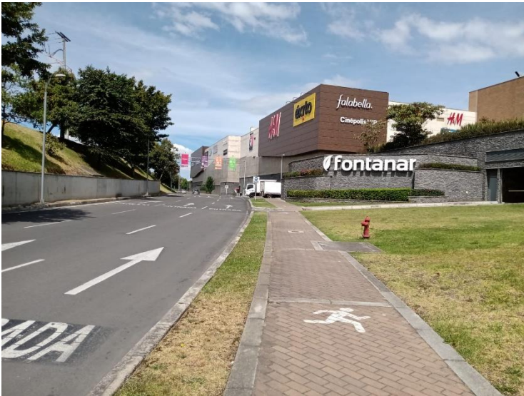
Ilustración 56. Vía circunvalar sobre la fachada principal del centro comercial, sobre la vía 45A. Archivo personal
