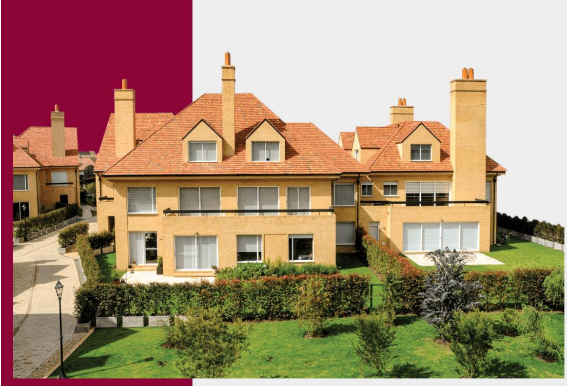
Ilustración 19: Casona de Santa Ana II. Tomado de: https://www.constructorasantaana.com/#proyecto
