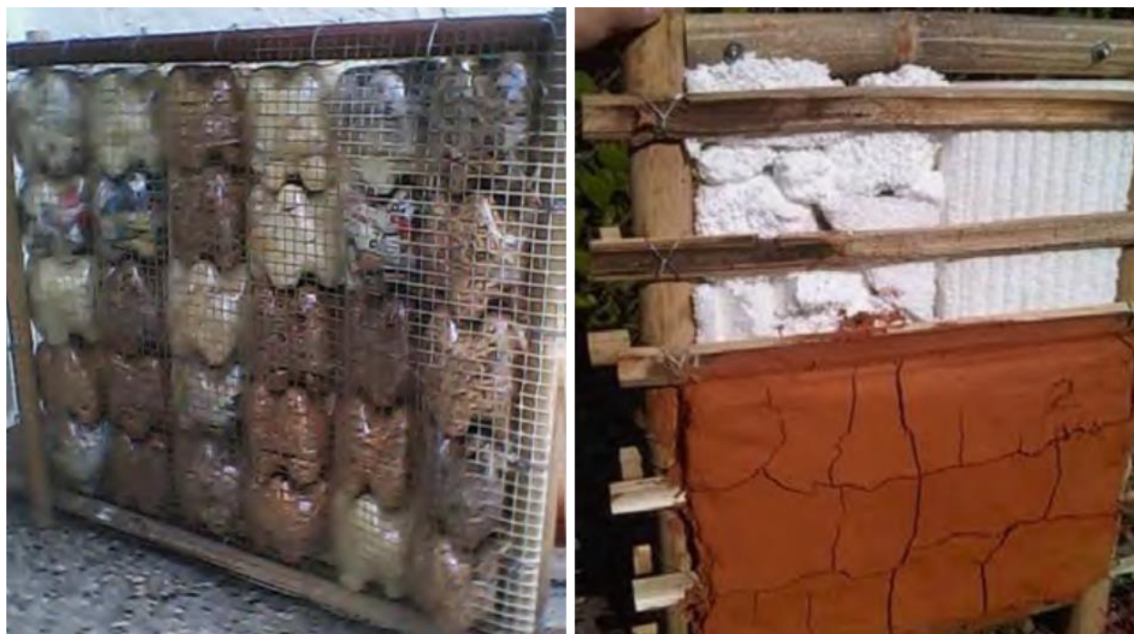
Figura 2-9: Innovación en la incursión de nuevos materiales en la estructura del bahareque. Fuente: Tres pasos para la recuperación de la arquitectura de tierra en el estado Zulia, Venezuela. Andrea Henneberg. 2014. pág, 240.
