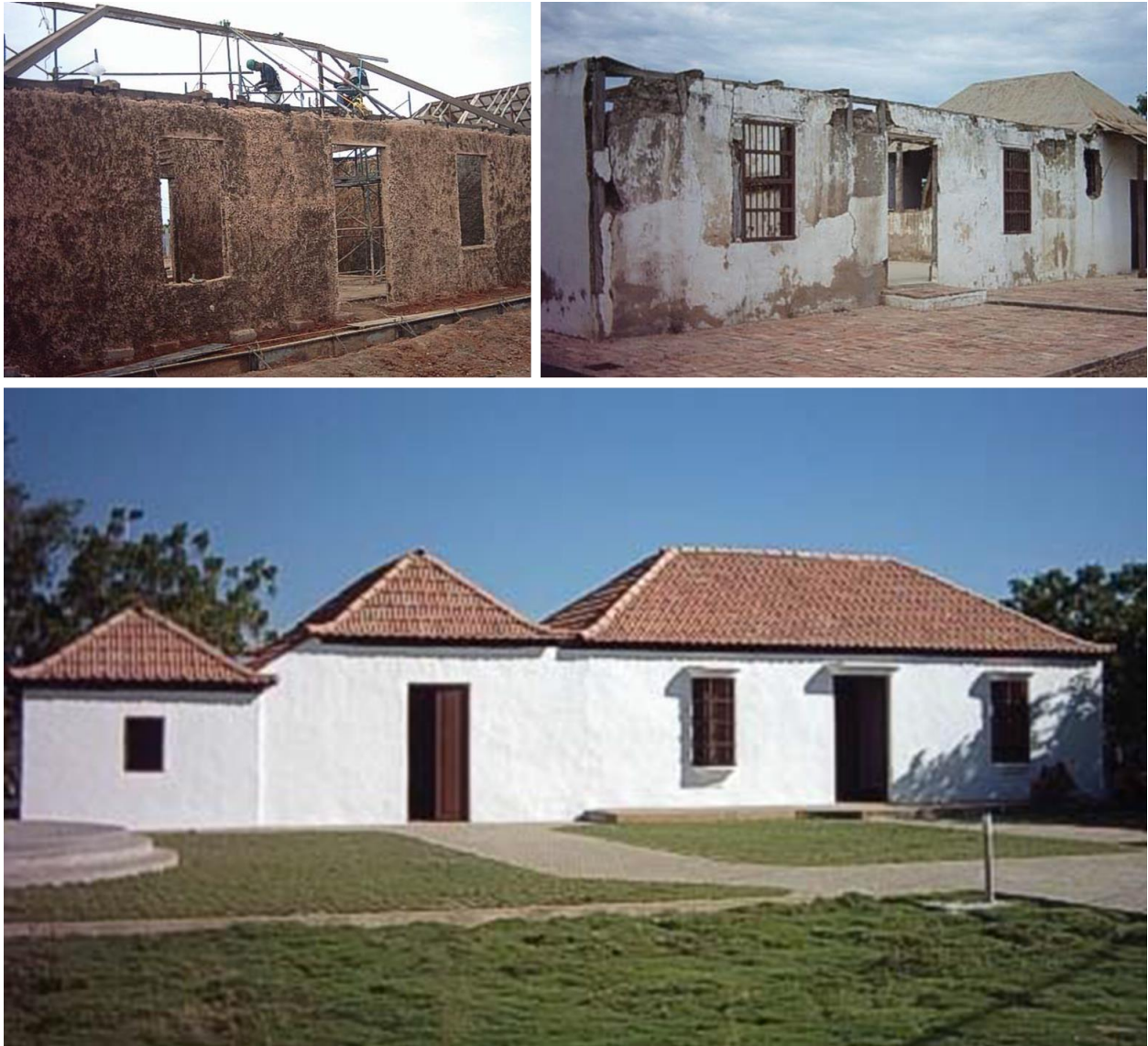
Figura 2-5: Rehabilitación Casa Natal de Rafael Urdaneta en Venezuela. Arquitectura en bahareque.
