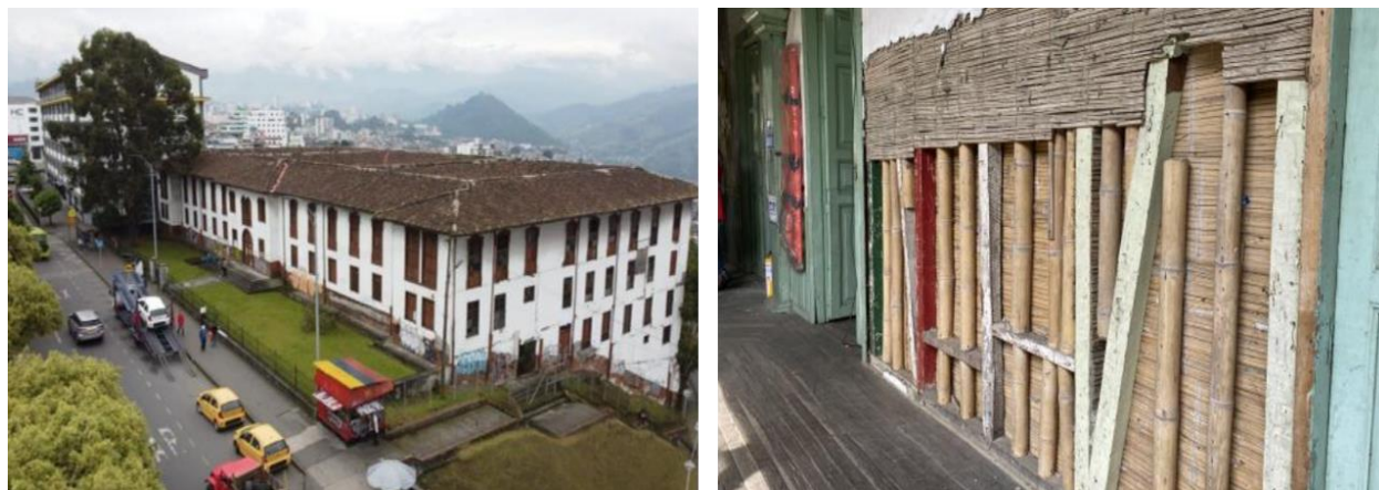
Figura 2-6: Restauración de la antigua escuela Juan XXIII, Manizales, Colombia.
