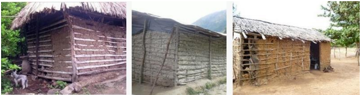
Figura 3-44: Fotos de viviendas en Bahareque con técnicas locales en diferentes regiones del país. Fuente: Elaborado por Gustavo González Castañeda (especialista en construcción sostenible) Medellín- Colombia.
