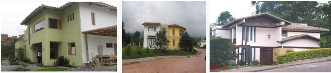
Figura 3-46: Fotos de casas en Bahareque terminadas, proyecto de la Estrella Antioquia (2007-2009).
