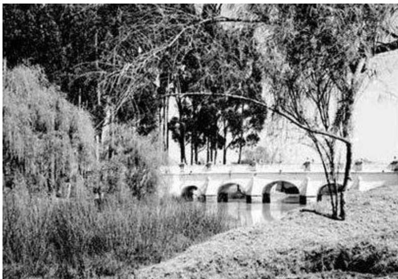
Figura 3-26. Fotografía del Puente del Común, años 2000.
