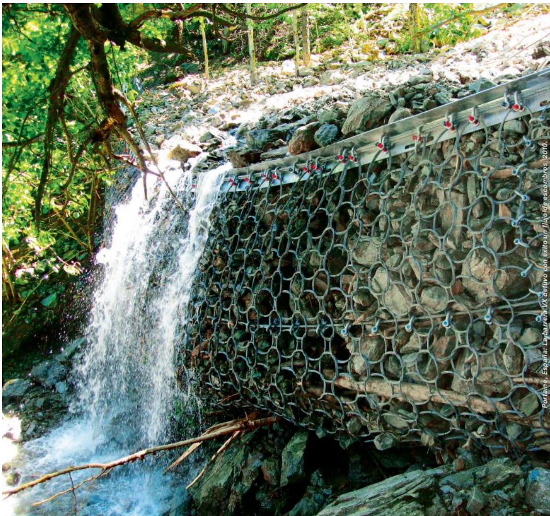
Figura 53 Barrera VX para retención de flujo de detritos. Fuente: (GEOBRUGG, 2023)
