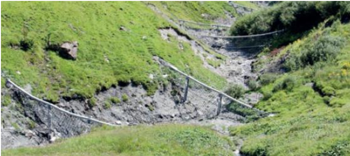
Figura 54 Barreras VX escalonadas. Fuente: (GEOBRUGG, 2023)
