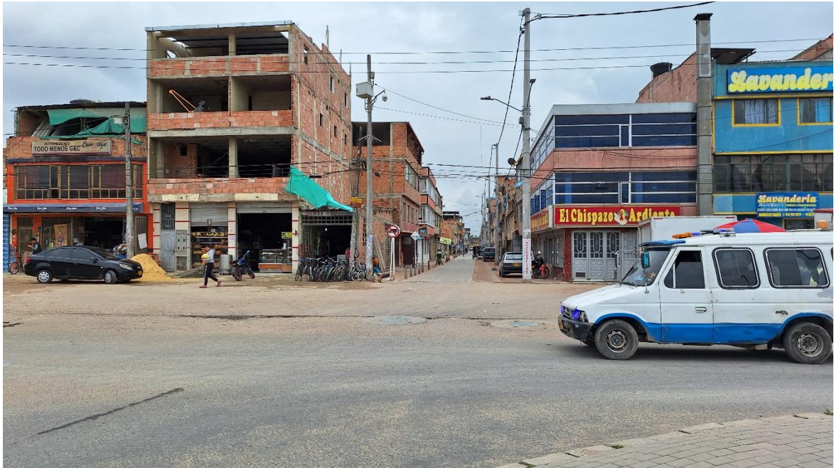
Figura 55. Estado del perfil de la calle 56F sur.
