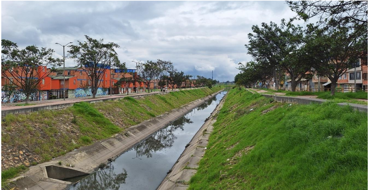
Figura 3. Canal Tintal III y entorno inmediato.
