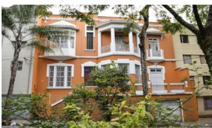
Ilustración 12 Casa de la Calle Miranda. Calle 60 (Miranda) # 47-15. Foto extraída de: https://centrico.com.co/casas/casa-de-la-calle-miranda/ (Octubre, 2021)
