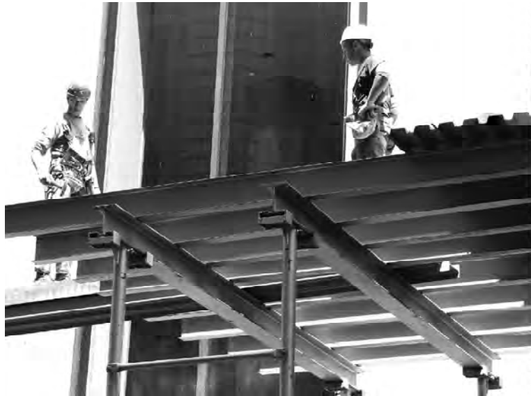
CONSTRUCCIÓN DE ESTRUCTURA METÁLICA, NUEVA YORK, 2005
