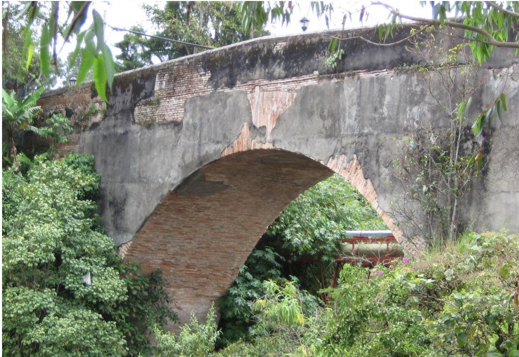
Ilustración 15. Alzada y fotografía del puente sobre el río Cauca, en Popayán. Fotografía del autor
