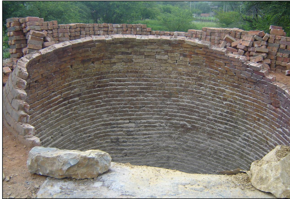
Ilustración 2. Imagen de un horno para el cocido de la cal en Vijes (Valle del Cauca)
