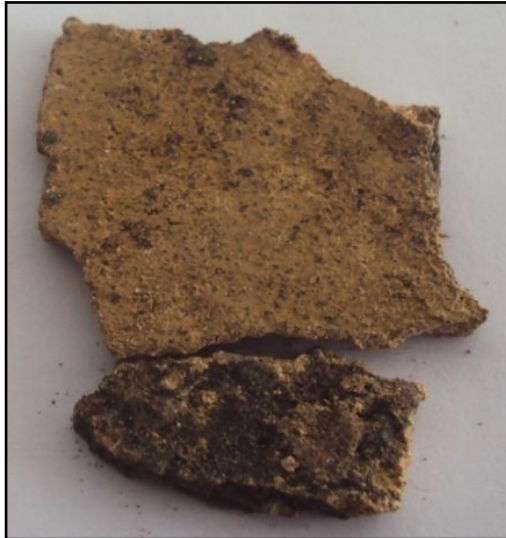
Ilustración 45. Muestra del mortero de revoque del puente Ortiz en Cali
