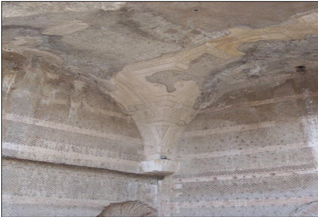
Ilustración 1. Interior de una bóveda romana donde se aprecian ladrillos pegados con mortero de cal y enlucido a base del mismo material. Foto cedida por J. Galindo (2008)
