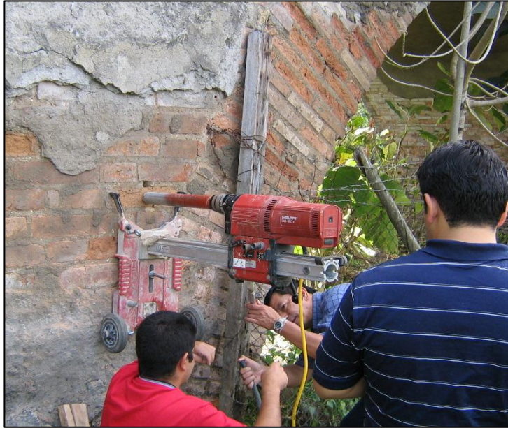
Ilustración 17. Extracción de núcleos del puente Cauca.
