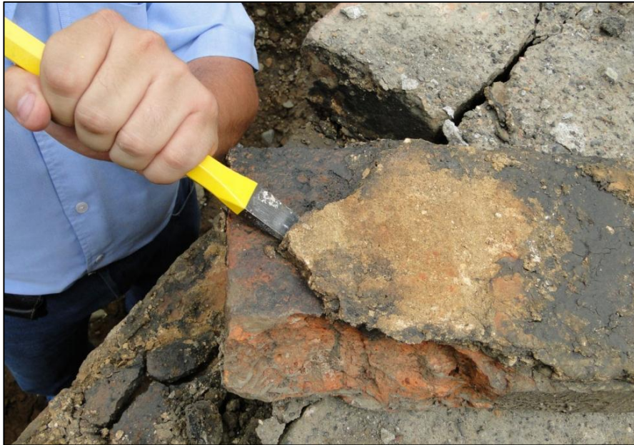
Ilustración 20. Extracción de muestras de mortero de pega del puente Ortiz
