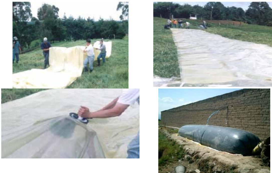
Figura 7. Secuencia fotográfica de la construcción de un biodigestor de balón plástico por parte de la misma comunidad beneficiada [Beckman et al. 2007].
