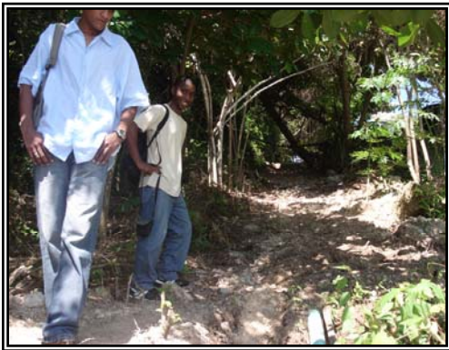
Foto 4. Instalación red de saneamiento.
