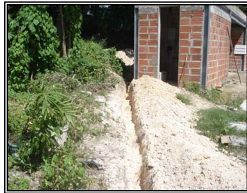
Foto 5. Instalación tubería red de saneamiento a nueva infraestructura.
