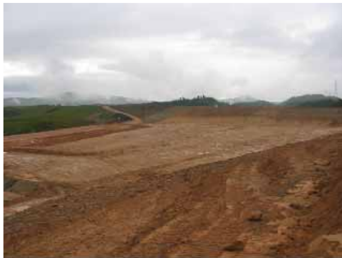
Figura 3.6 Panorámica de los llenos en presa auxiliar II
