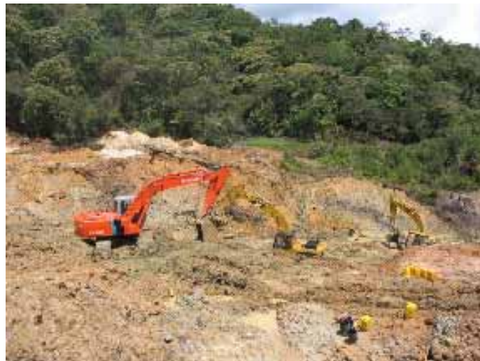
Figura 4.2 Excavación en zona baja I
