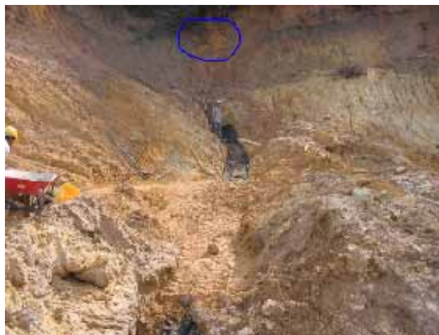
Figura 4.3 Filtros en zona baja I y la dificultad por las pendientes del terreno
