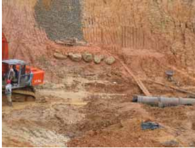
Figura 4.4 Construcción de colectores en zonas demasiado pantanosas
