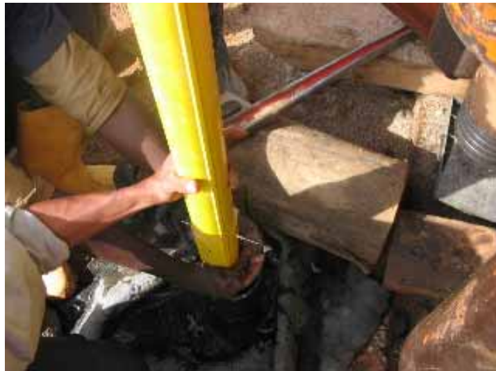
Figura 3.7 instalación de piezómetro de alambre vibratorio
