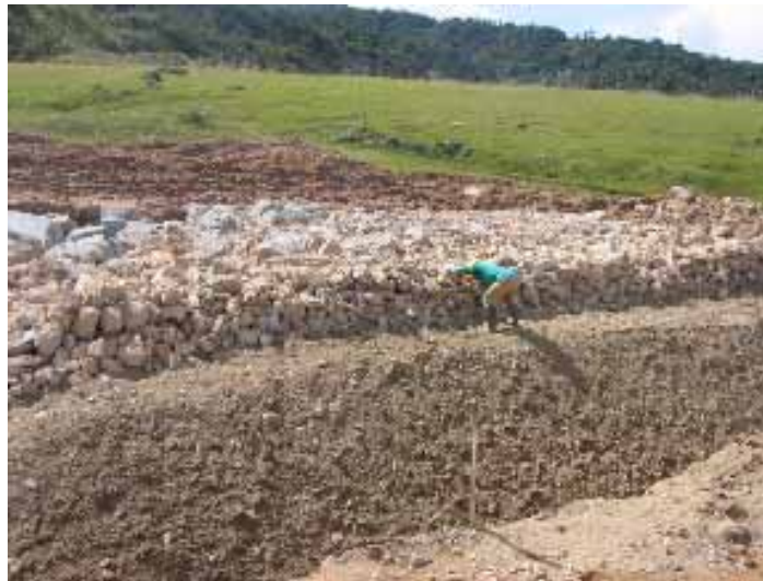
Figura 3.5 Pedraplen hecho en Presa Auxiliar II.
