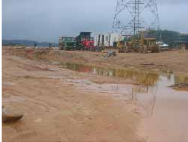
Figura 6.2 se observa la maquinaria parada por efectos del invierno
