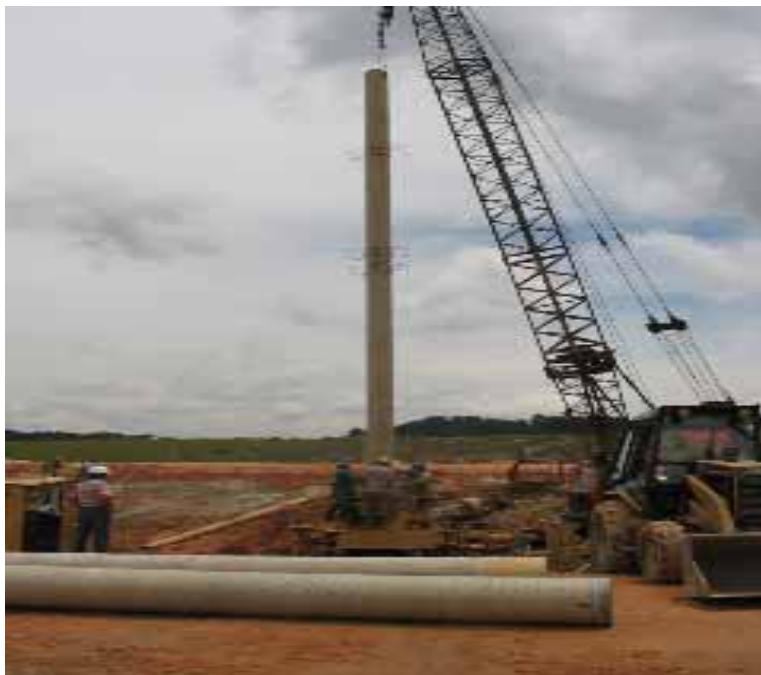
Figura 3.2 Colocación de tubo para la conformación de pozos de drenaje.
