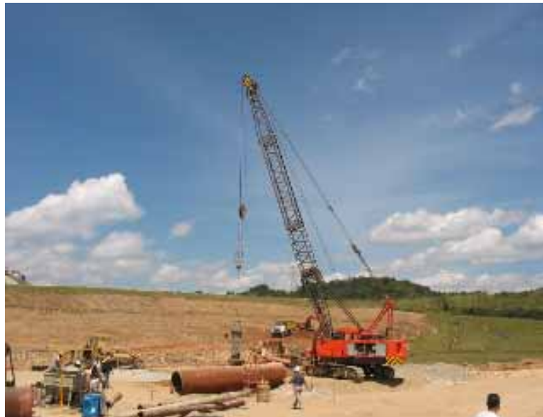
Figura 3.1 Proceso de excavación con Grúa para pozos de drenaje
