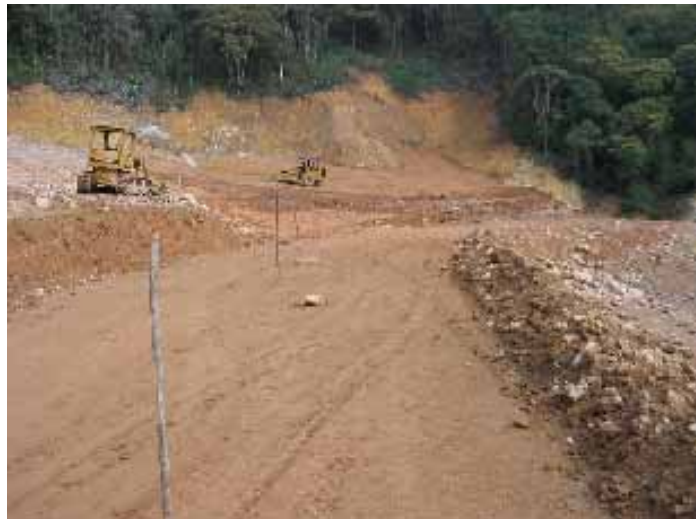
Figura 4.6 Maquinas extendiendo y compactando material en zona baja I
