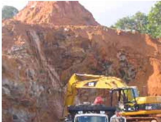
Figura 6.6 Calidad del material excavado en el préstamo 1
