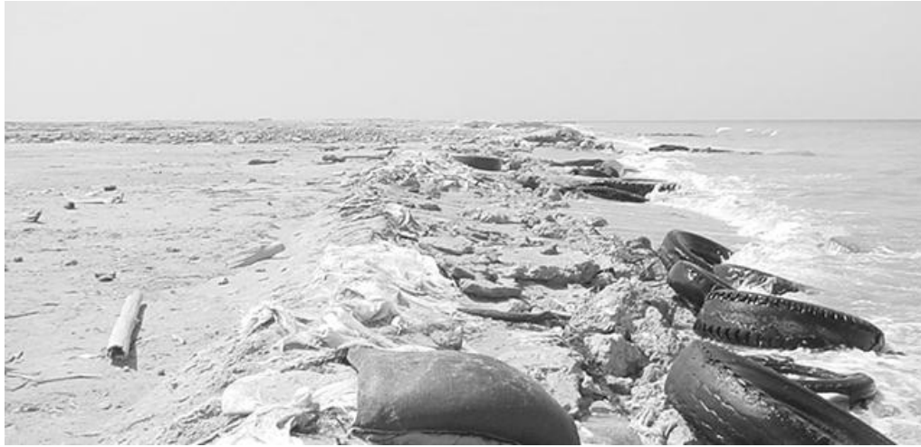
Figura 7. Muros de contención y espolones realizados hacia el borde de la salina para contener el ingreso del mar. Durante épocas de oleaje fuerte, éste ingresa a la misma salina acarreado consigo la pérdida de la producción.
