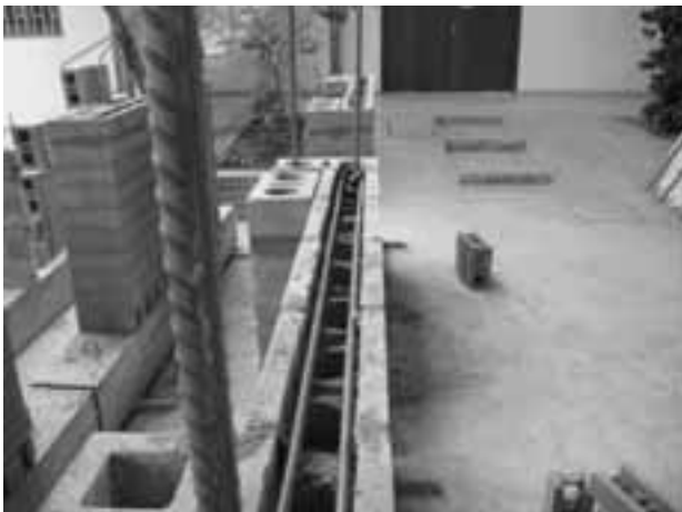
Fotografía 1. Acero de refuerzo localizado dentro de celdas especiales
