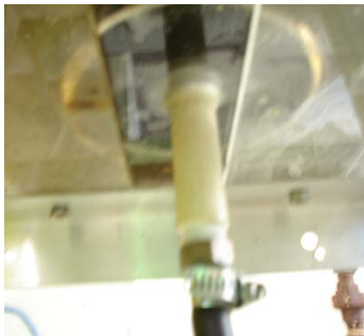
Figura 6. Tubería de alimentación.
