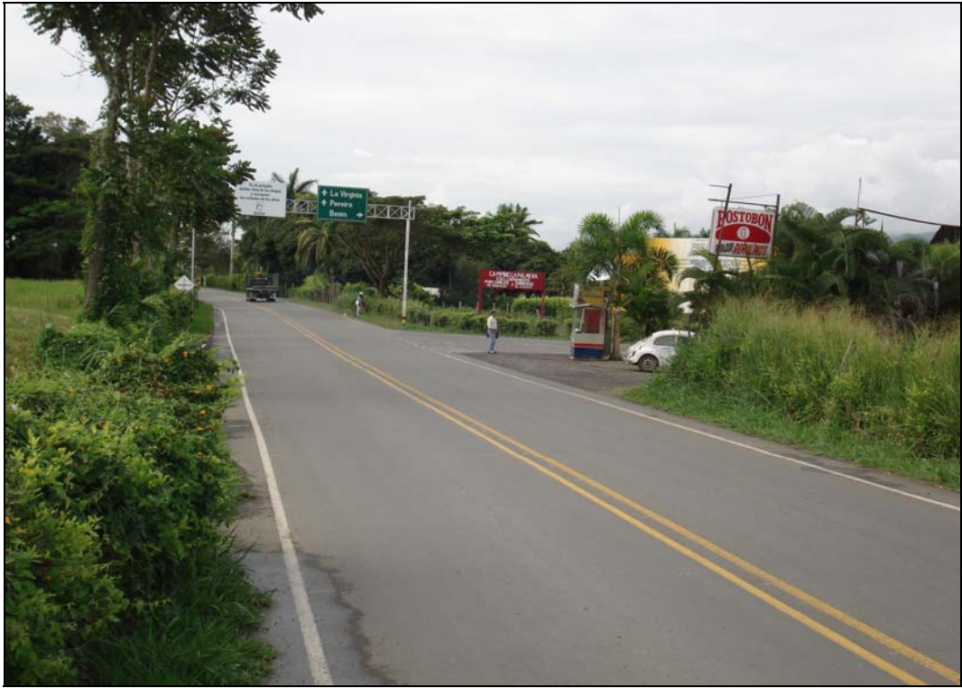
FIGURA No. 2: VISTA EN EL SENTIDO ANSERMA – PEREIRA.
