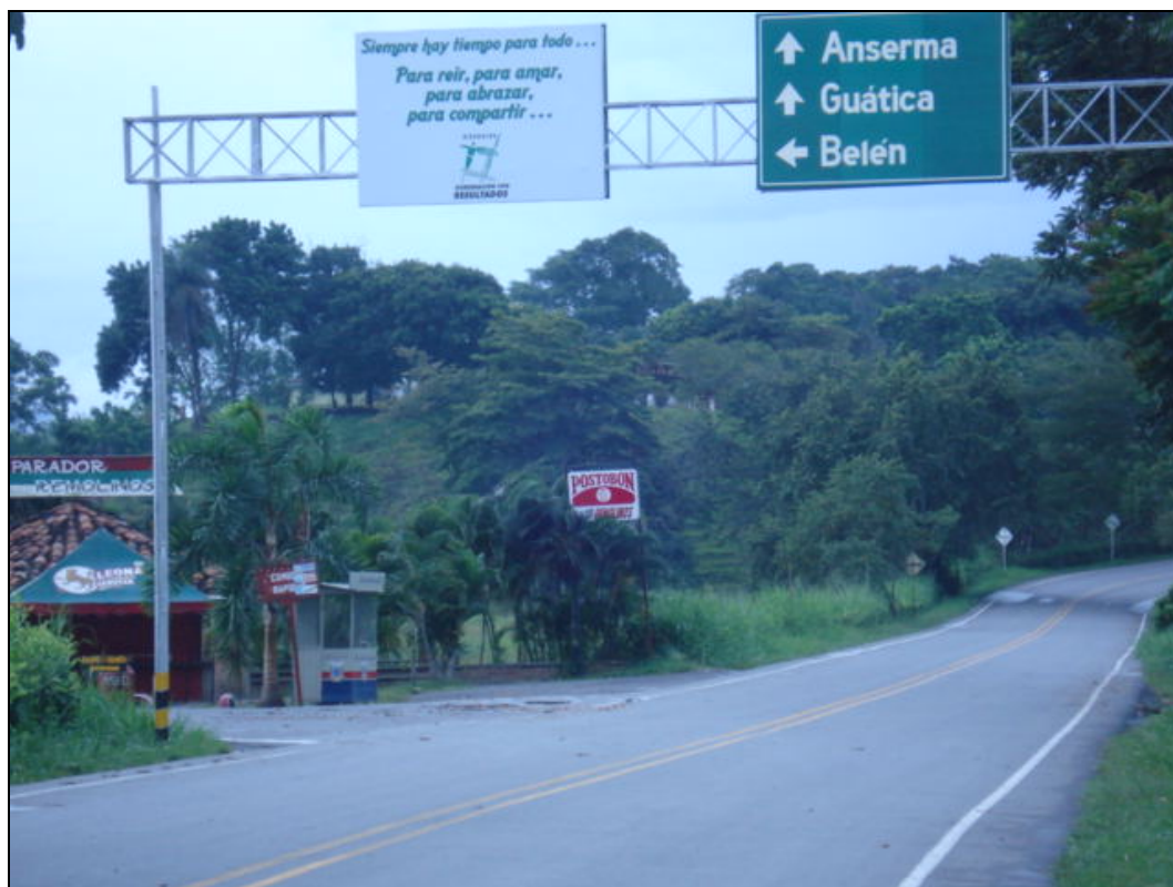
FIGURA No. 1: VISTA EN EL SENTIDO PEREIRA – ANSERMA.
