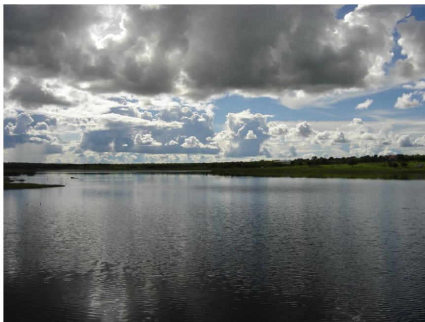
Figura 2 – Açude Santa Bárbara, em Jaguaratama.
