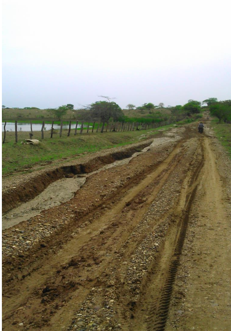
Foto 1. Vía principal de la cabecera municipal de Chibolo hacia las veredas de La Pola y La Palizúa.
