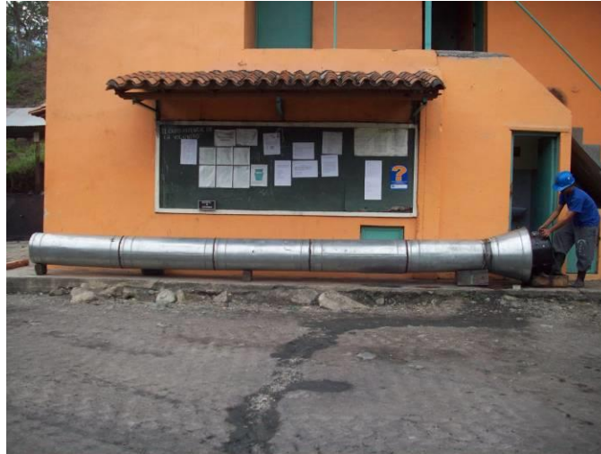
Figura 10. Montaje ventilador ducto
