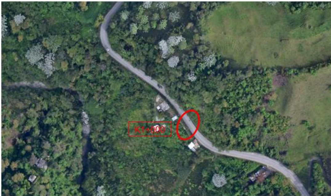
Figura 29. Panorámica del punto crítico K1+000
