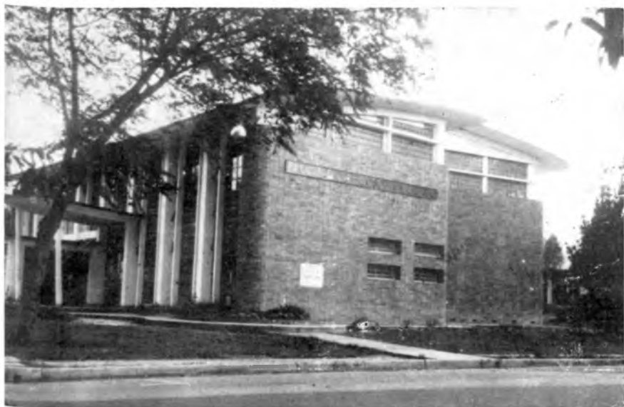
Vista del ángulo occidental del nuevo edificio.
