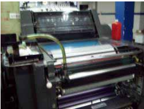
Figura 11. Maquinaria de proceso.
