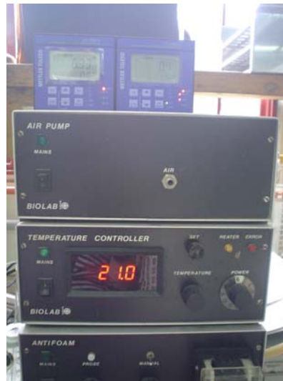
MODULOS DE MEDICION Y CONTROL
