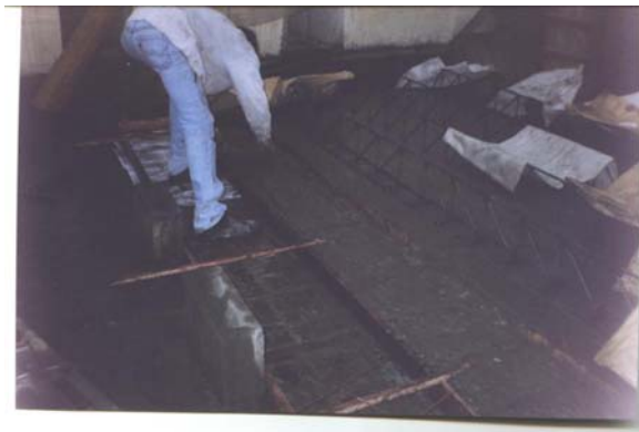
Imagen 5: Instalación de vigueta metálica con conector de cortante.
