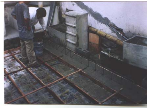
Imagen 4: Instalación de vigueta metálica con el cordón en compresión embebido en el concreto.
