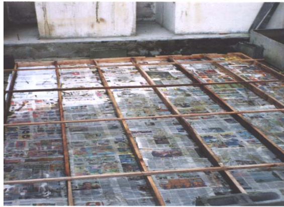
Imagen 1: Formaleta para las losas de concreto de las viguetas compuestas.
