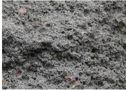
Figura 13 Apariencia microscópica del mortero con adición del 0,2 % de aditivo proteínico (9)
