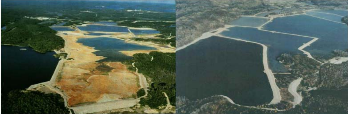
Foto 2. Depósito de Relaves de la Mina Quirke antes y después del Cierre
