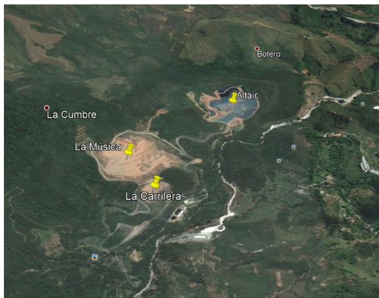
Figura 4-1. Vista General Relleno Sanitario La Pradera. Adaptado de Imagen satelital tomada de Google Earth.
