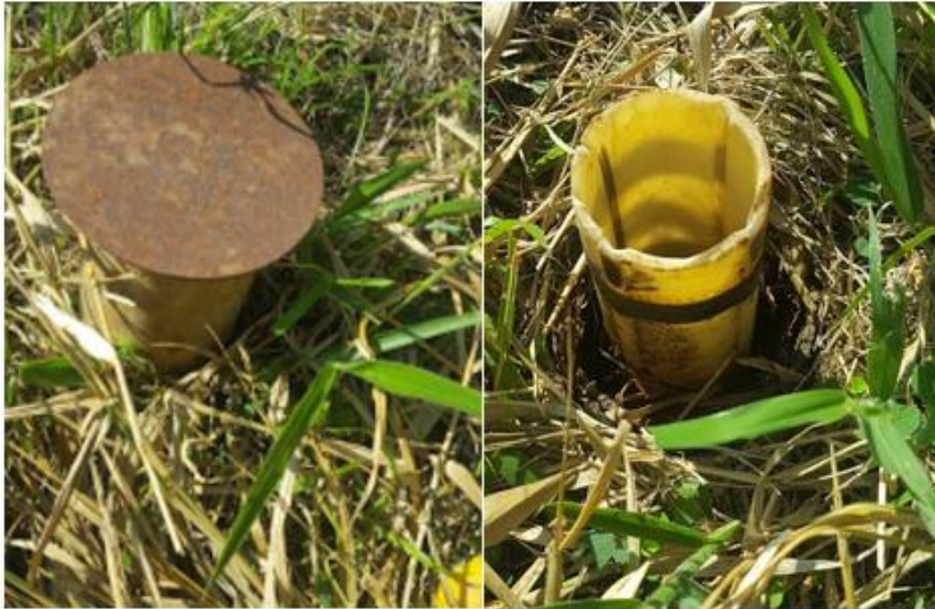
Figura 6-10. Instalación de tubería para los sondeos desplazamientos con el inclinómetro, octubre 2017.
