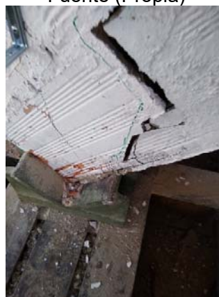
Imagen 22 Ensayo tensión diagonal 2. Fuente (Propia)
