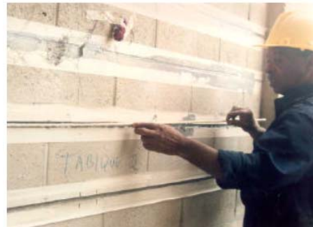
Figura 1-10 Reforzamiento con varillas de vidrio 2. fuente (Tumialan et al., 2007)
