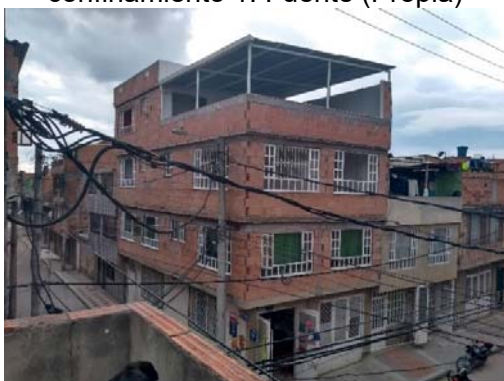
Figura 1-4 Viviendas mampostería sin confinamiento 1. Fuente (Propia)
