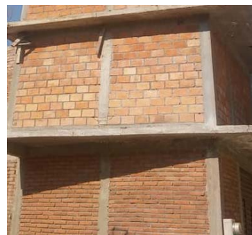
Figura 1-3 Mampostería confinada 2. Fuente (Propia)
