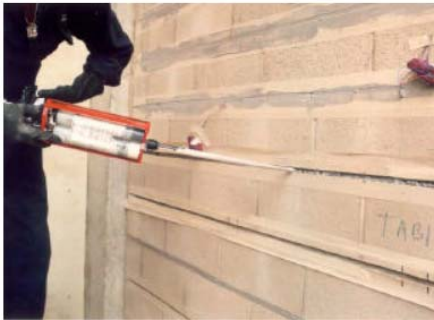
Figura 1-9 Reforzamiento con varillas de vidrio 1. fuente (Tumialan et al., 2007)
