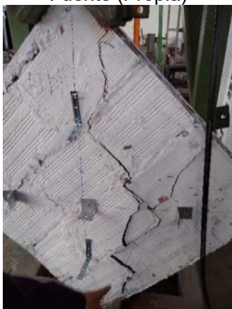
Imagen 21 Ensayo tensión diagonal 1. Fuente (Propia)
