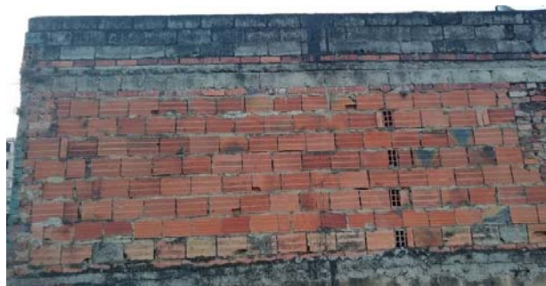
Figura 1-1 Muro de mampostería sin reforzamiento 1. Fuente (Propia).
