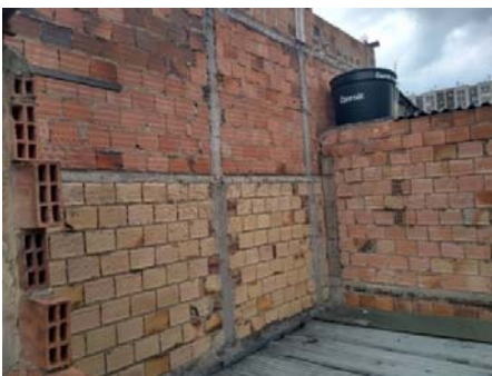
Figura 1-2 Mampostería confinada 1. Fuente (Propia)
