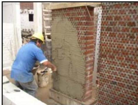
Figura 1-12 Refuerzo con mallas de polímero 2. Fuente (Dávila, 2011)
