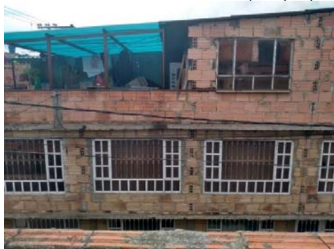
Figura 1-5 Viviendas mampostería sin confinamiento 2. Fuente (Propia)
