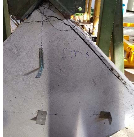
Imagen 26 Ensayo tensión diagonal 6. Fuente (Propia)
