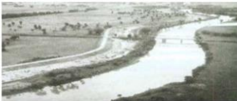
Figura 27: Panorámica Construcción Jarillón del río Cauca, 1959.
