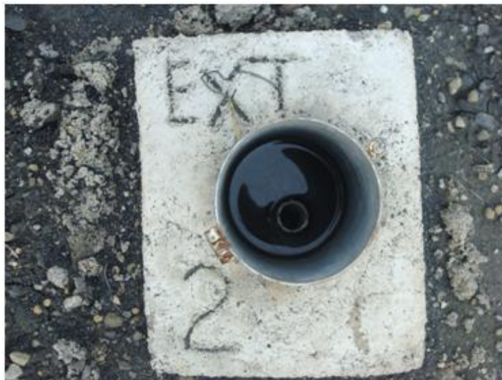
Fotografía 29. Extensómetros instalados en rellenos de contrapeso. (Foto:2010).
