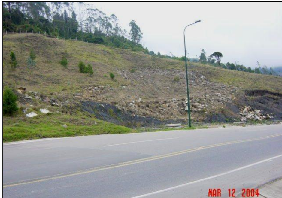
Fotografía 34. Corte en cajón en rocas lodosas K4+400, carretera Bogotá-Villavicencio. Foto: C. Palomino 2004.
