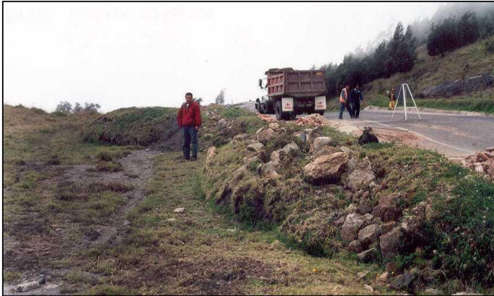
Fotografía 35. Levantamiento de banca K6+800, carretera Bogotá-Villavicencio. Foto: C. Palomino 1999.
