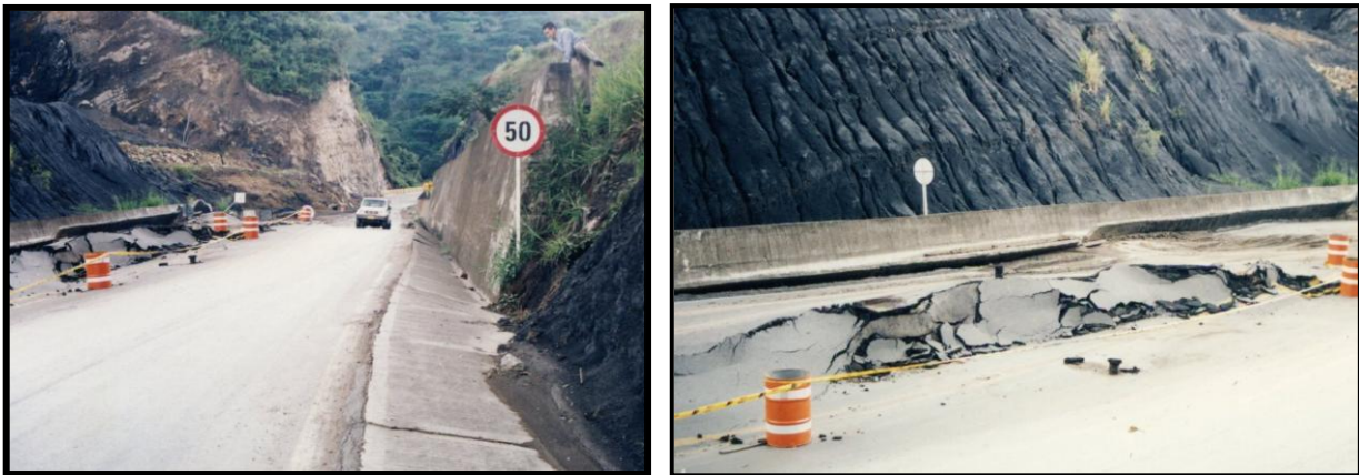
Fotografías 45 y 46. Levantamiento fuerte de la banca. Fotos: C.Palomino S, años 1999 a 2000.
