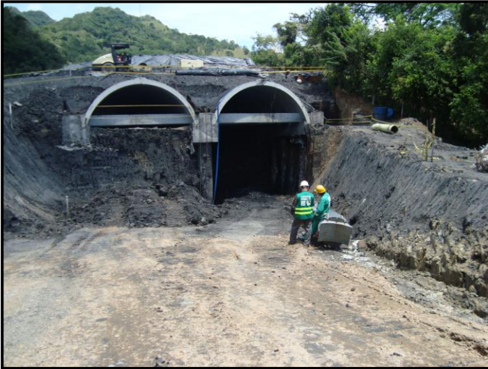
Fotografías 47 y 48. Sección actual del túnel falso y relleno de contrapeso en zona superior de la bóveda. Feb. 20 /2011. Fotos: C.Palomino S.
