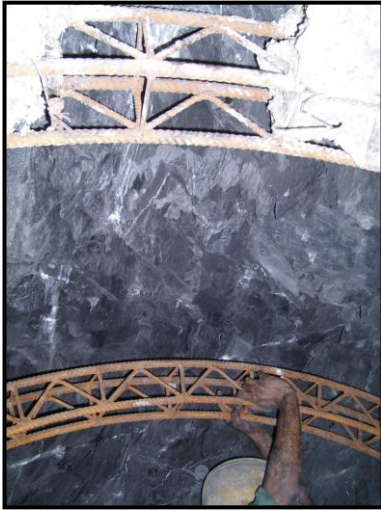
Fotografías 39 a 41. Galería de drenaje. Proceso de revestimiento y funcionamiento en el sector de las abscisas K0+050/070. Junio 2010 2010.
