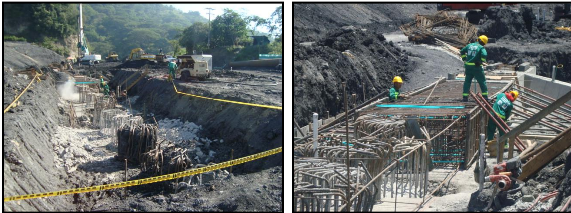
Fotografías 43 y 44. Construcción de vigas de amarre longitudinales, agosto de 2010
