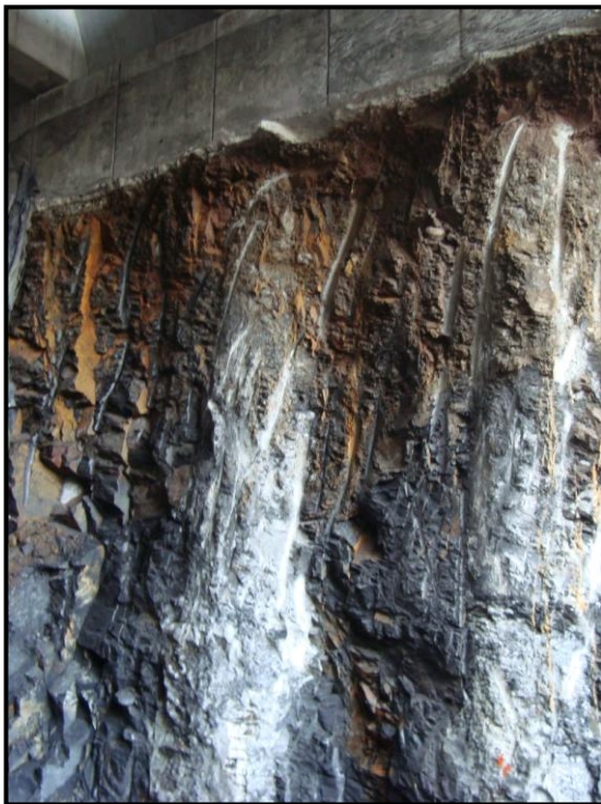
Fotografías 49 y 50. Pantalla de pilotes del eje 4. Se observa el macizo rocoso y los pilotes de concreto. Febrero 20 de 2011.
