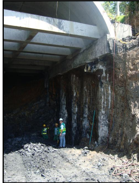
Fotografías 47 y 48. Sección actual del túnel falso y relleno de contrapeso en zona superior de la bóveda. Feb. 20 /2011. Fotos: C.Palomino S.
