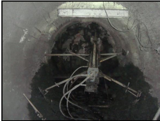
Fotografía 42. Frente de excavación de la galería, agosto de 2010.
