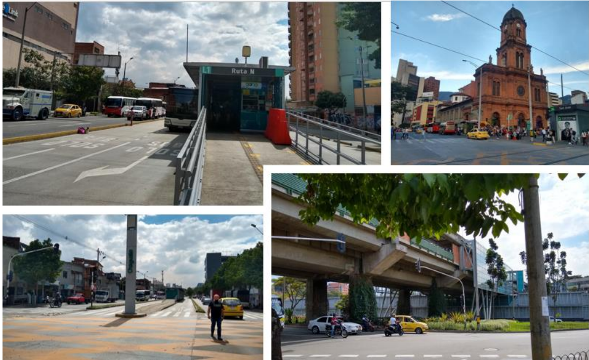
Figura 5-8: Estaciones del Metroplús: Ruta N, San José, Chagualo y Hospital.
