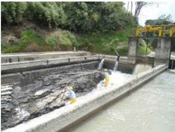
a. Movimientos de lodo manual para su descarga.
