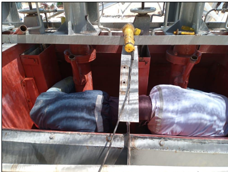
Imagen 2. Instalación de aireación asistida.
