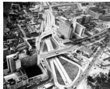
Imagen 4- 22. Viaductos de la calle 26. 1963
