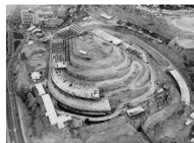
Imagen 4- 73. Construcción del centro comercial Helicoide sobre la roca Tarpeya. Caracas. 1956
