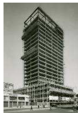
Imagen 4- 42. Banco de Bogotá en construcción.
