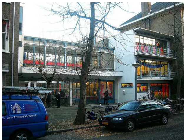
Acceso desde la vía pública.
