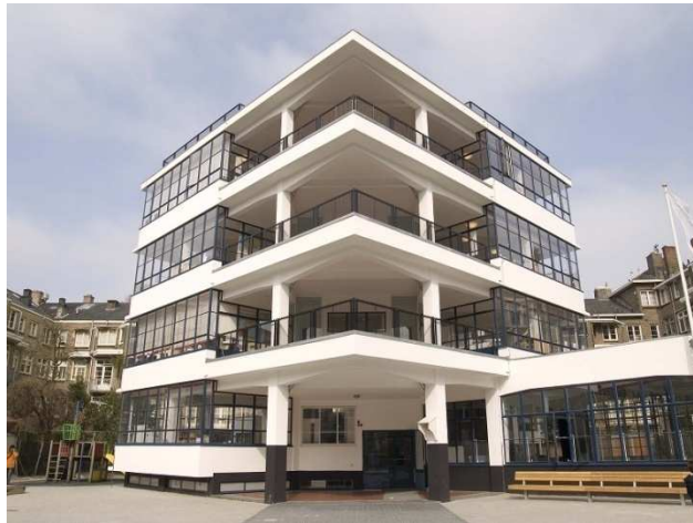
Vista de la caja abierta
