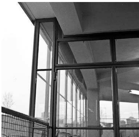
Detalle de la ventanería.
